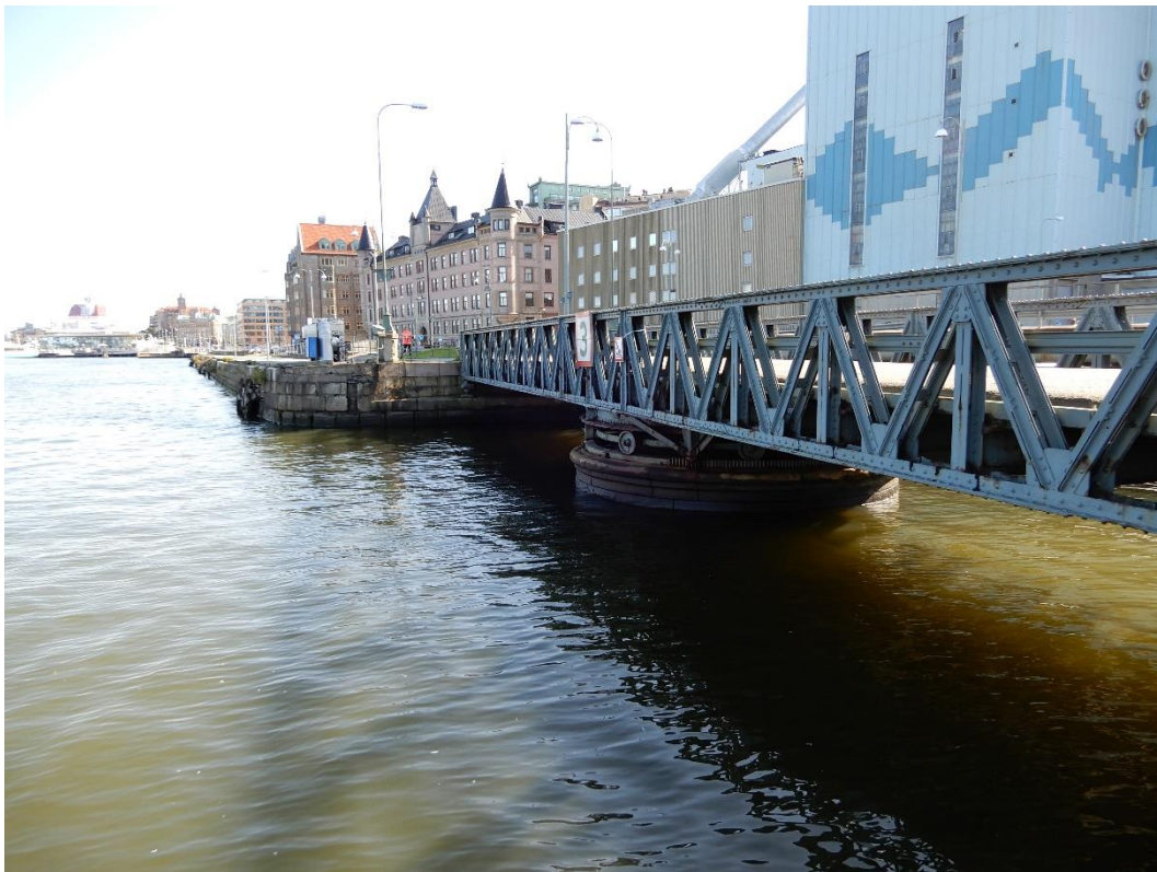
Figur 2. Yttre Järnvågsbron innan den flyttades. På bilden syns brofästet på Skeppsbrosidan samt mittstödet i Rosenlundschanalen vilka planeras att rivas och avses ingå i planerad tillståndsansökan.
